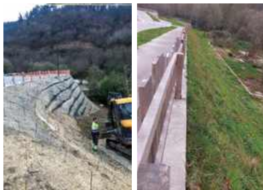
Obran zehar ezponda egonkortzea bioingeniaritza erabiliz (goi eta azpi ezkeralderako argazkiak) eta urte erdi igaro ondoren (behe eskuinaldea).
