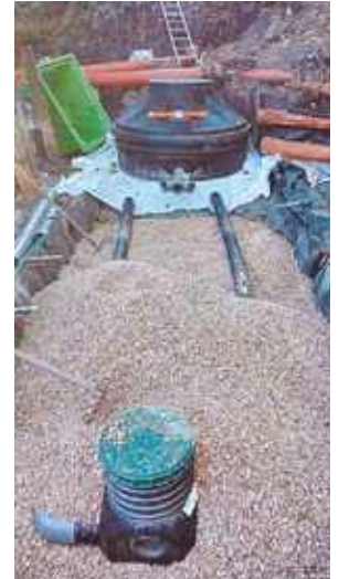
Hobiaren bi zatiak zigilatu ondoren ekipoak instalatzea eta hezeguneak betetzea.
