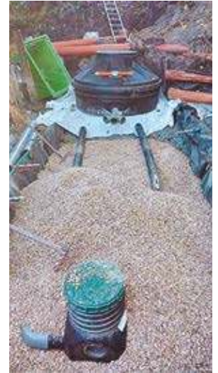
Instalación de equipos y relleno de humedales tras el sellado de las dos partes de la fosa.
