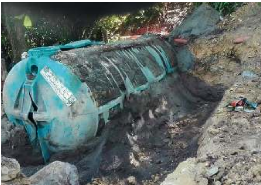
Excavación anexa a la fosa séptica preexistente.
