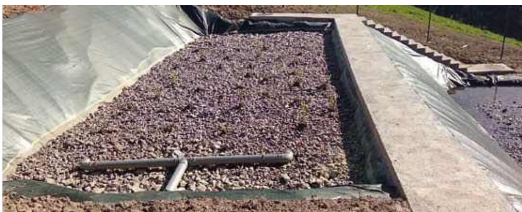
Hezegunearen beheko hodia. Bertan, granulometria ezberdineko legarreko iragazte-substratua ikusten da, 60 cm-ko lodiera duena. Bertan urpeko landaredia finkatzen da.
