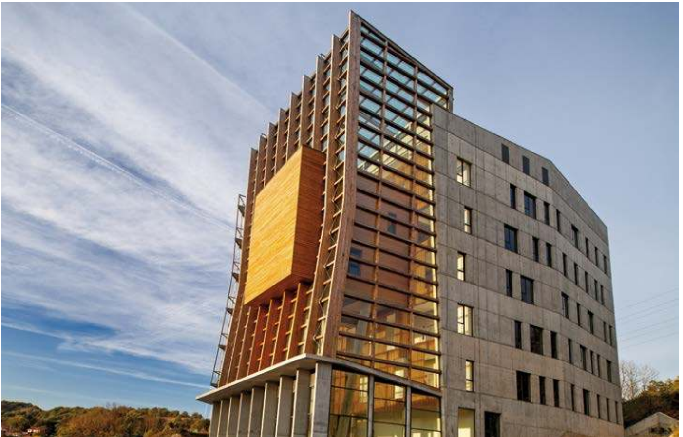
Vista exterior del edificio ENERTIC.
