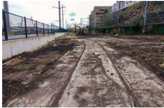
Aspecto de la parcela tras el desbroce y nivelado del terreno.
