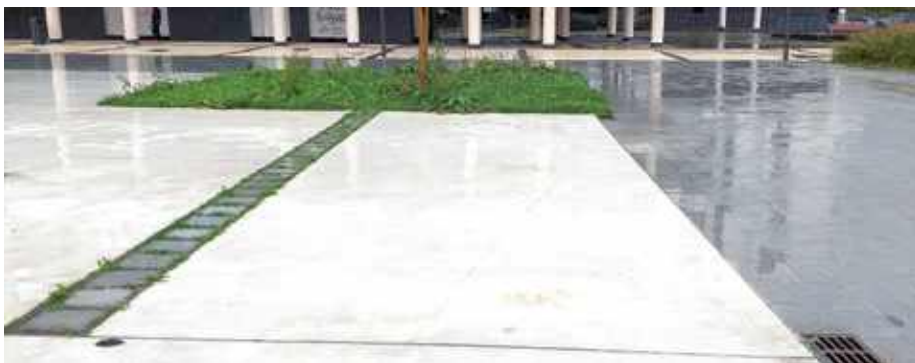
Drainatze zerrenda obra amaitu ondoren (ezkerrean) eta euri-urak biltzeko kutxeta arrunta (eskuinean).
