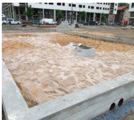
Arqueta de acceso en fase construcción.
