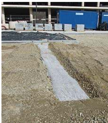
Proceso de construcción de las franjas drenantes.
