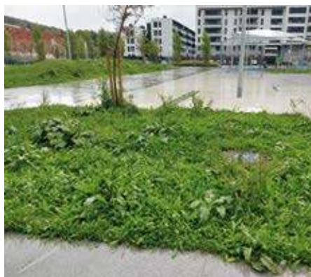
Jardines de lluvia tipo (a): césped con mezcla de festuca, chamomilla y raygrass, con una longitud de siega de 40 mm.
