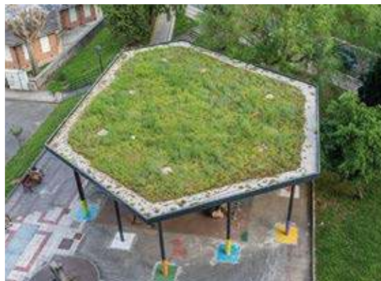
Imágenes que muestran el proceso de instalación de la cubierta verde en el parque infantil de Laubide.
