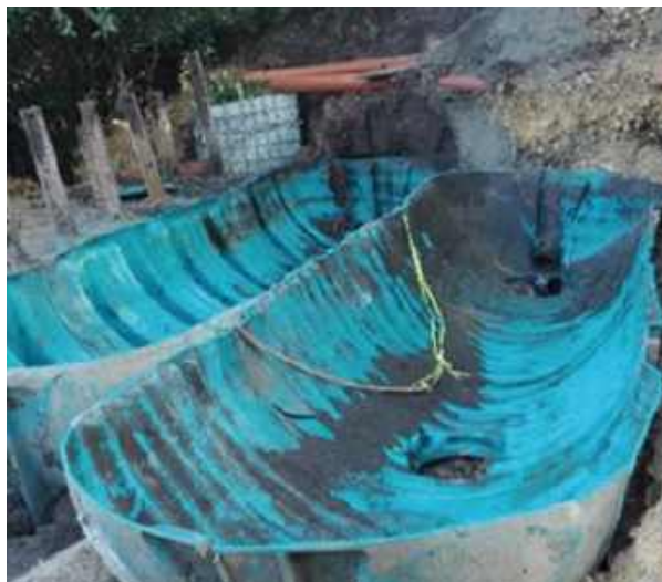
Hobi septikoaren bi erdiak, arazketa-sistema ezartzeko, hura hustu eta hobia moztu ondoren.
