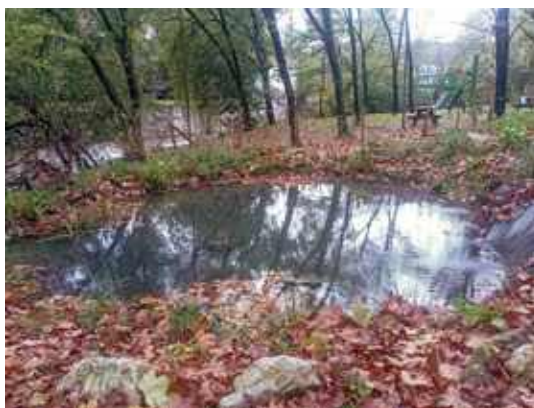
Fitoarazte-putzu konektatuak (goian, legarren eta helofiten iragazki-putzua, eta, behean, hezegune-putzua).
