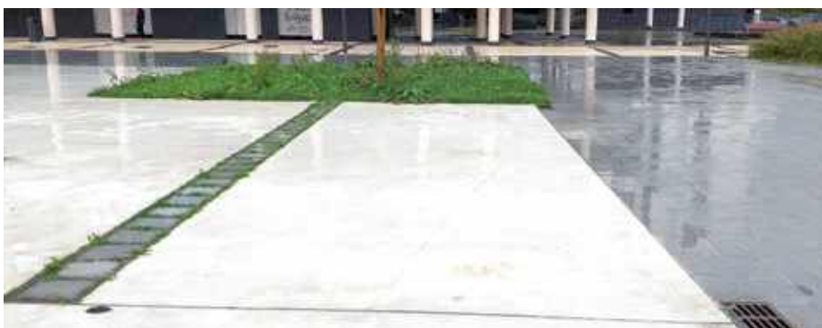
Drainatze zerrenda obra amaitu ondoren (ezkerrean) eta euri-urak biltzeko kutxeta arrunta (eskuinean).
