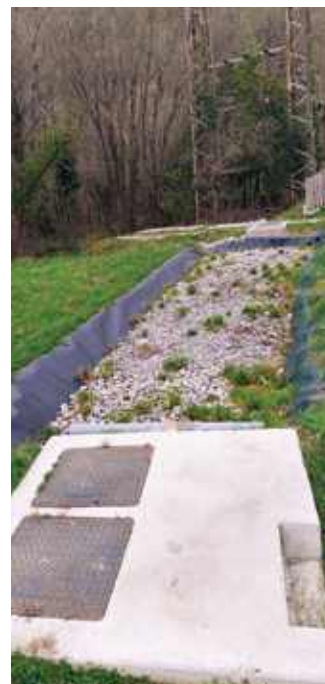
Fitoarazketa-sistema eta koipeak bereizteko kutxatila.
