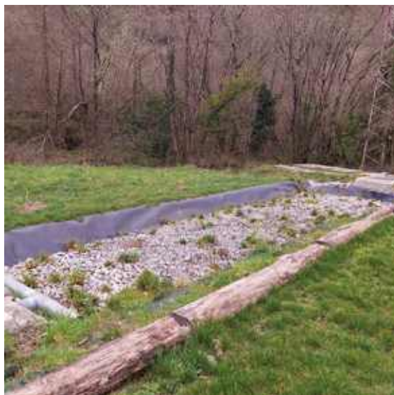
Fitoarazketa-sistema eta koipeak bereizteko kutxatila.
