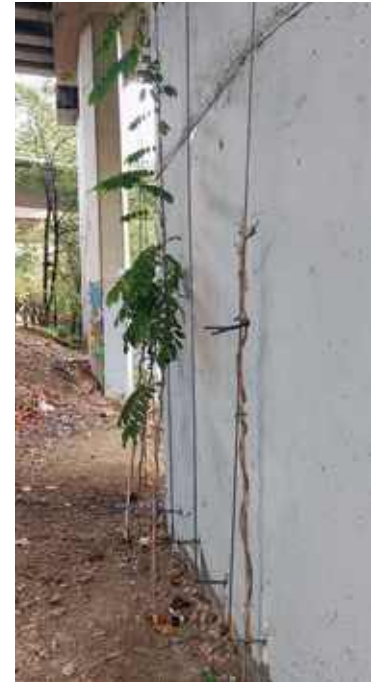
Zutabeen ainguratutako kableak, tarte bat dutela.
