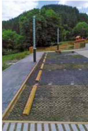
Aparkaleku-plazentzat tonu desberdinetako legarrez betetako birziklatutako polipropilenoazko gelaxkak.
