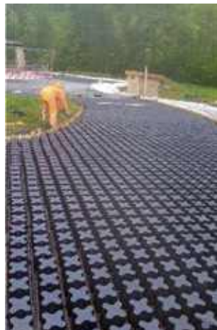
Ibilgailu gurpildunetarako trafiko-bideetarako hormigoizko lauza zulatuak obran jartzea.
