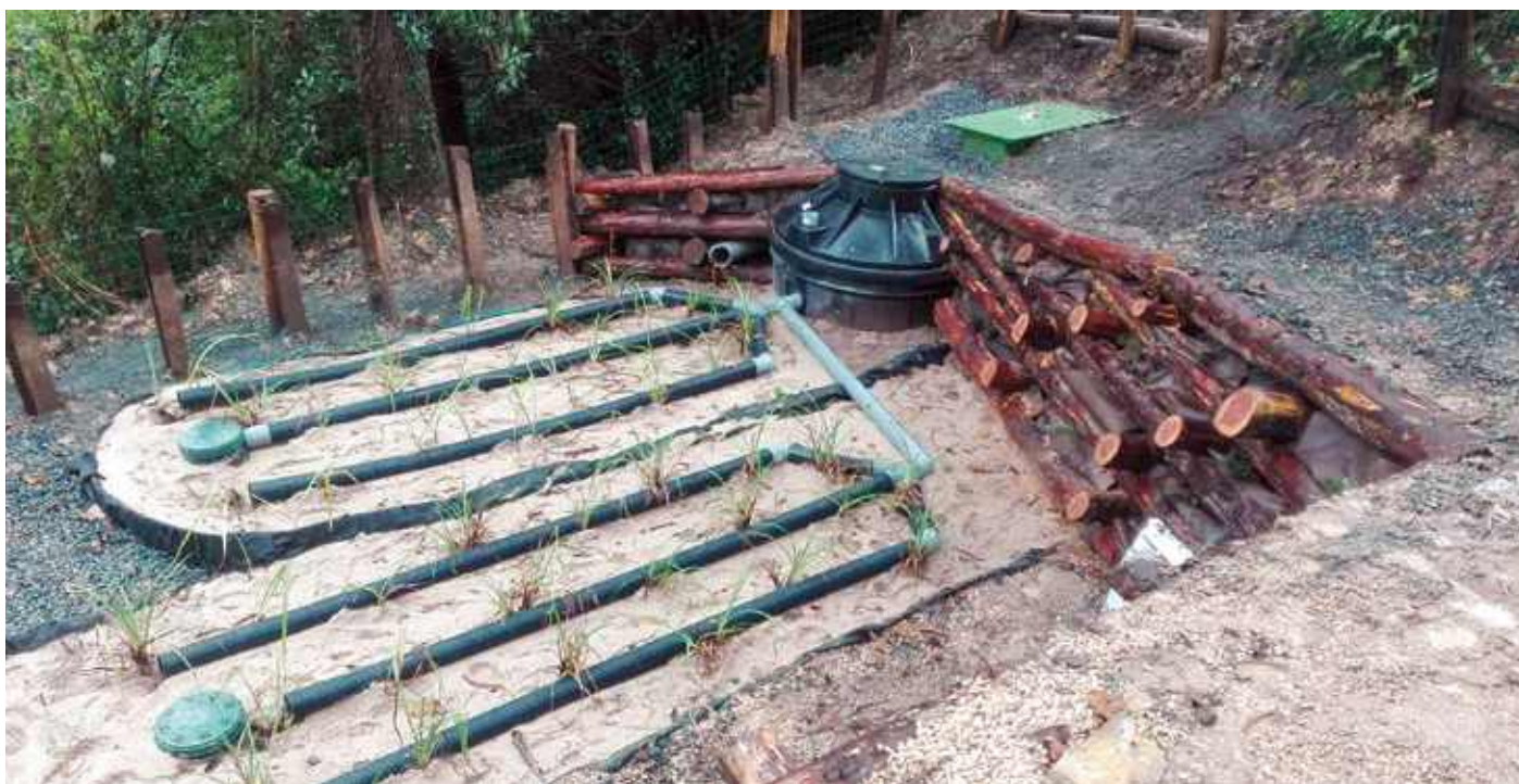
Fitoarazketa eta iragazketa mekaniko-biologikoko sistemaren itxura orokorra, esku-hartzea amaitu ondoren.
