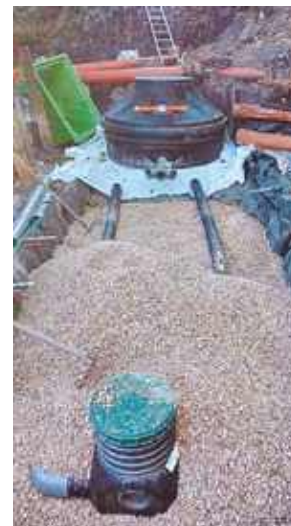
Hobiaren bi zatiak zigilatu ondoren ekipoak instalatzea eta hezeguneak betetzea.
