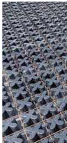
Ibilgailu gurpildunetarako trafiko-bideetarako hormigoizko lauza zulatuak obran jartzea.
