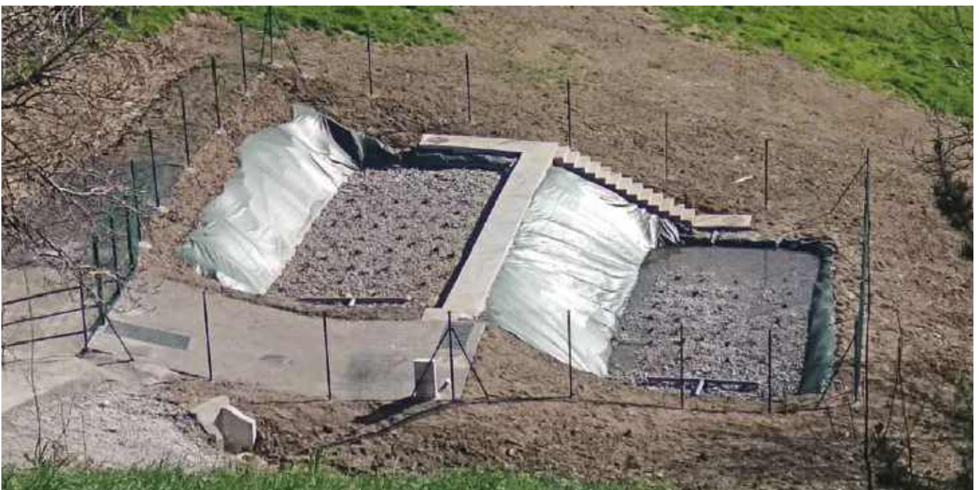
Merru auzoan egindako lurpeko fluxu horizontaleko mikrofitoak dituen hezegune artifizialaren ikuspegi orokorra.
