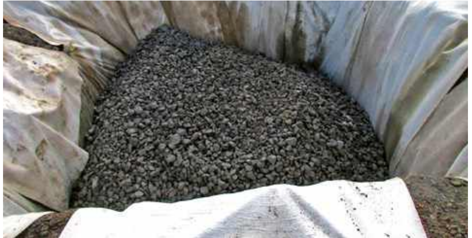
Infiltrazio-putzuetarako 6 m-ko sakonerako legar-zutabea, drainatzea ziurtatzen duena.
