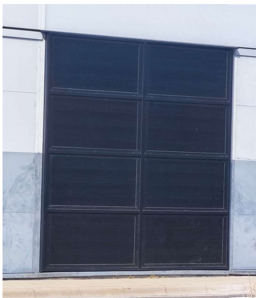
Instalación F. Solar Térmica en MBE Vitoria
