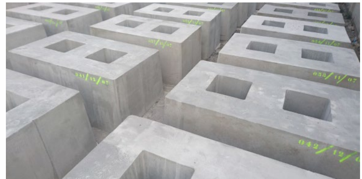
2016 – Dique de Zumaia
