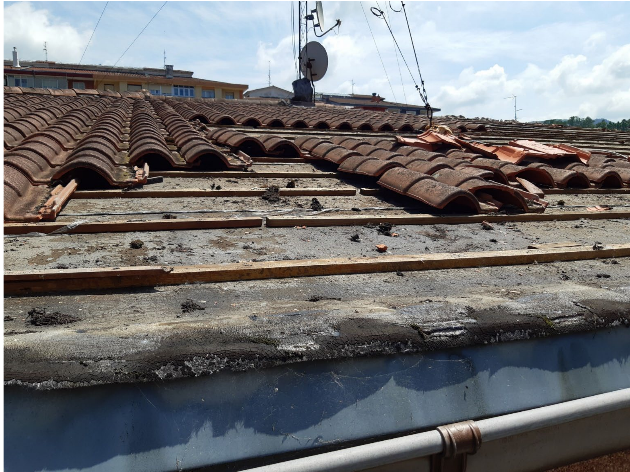
Agian hemen ez duzue ikusiko, baina amiantodun fibrozementuzko plaka uhinduak daude.
