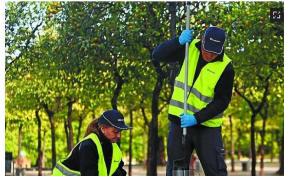
Smart Trap. Dos empleados de Anticimex insertan la máquina en las conducciones del alcantarillado de otra ciudad. DV
