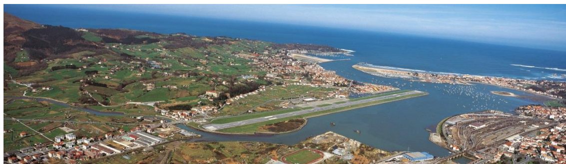
Figura 37. Vista aérea del estuario del Bidasoa.
