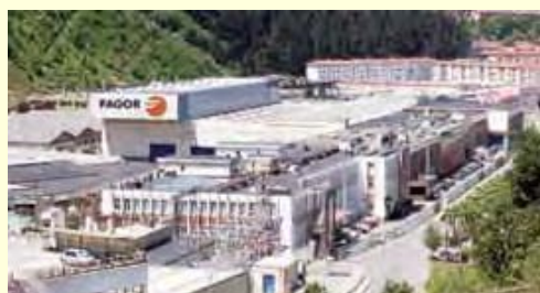
Instalaciones de FAGOR ARRASATE S. Coop
