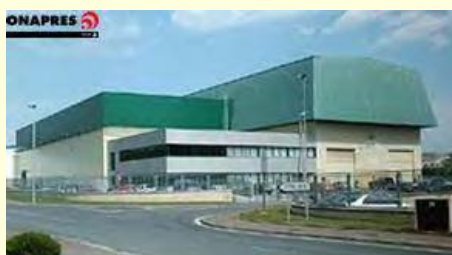
Instalaciones de ONAPRES
