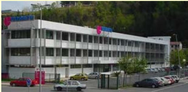
Instalaciones de GORATU en Elgoibar (Guipúzcoa)
