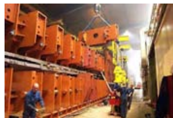
Rebaje de nervios realizado en columna de prensa. Movimiento de estructuras fijas de prensa en el montaje. Fuente: Onapres, SMG
